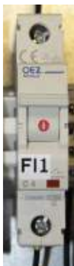
Рис. 18 Комбинированный предохранитель
