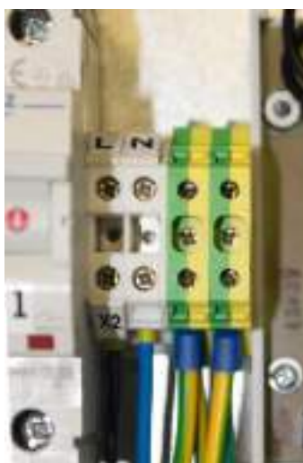
Рис. 10 Клеммы источника питания
