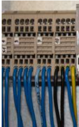
Рис. 11 Соединительные клеммы сигналов
